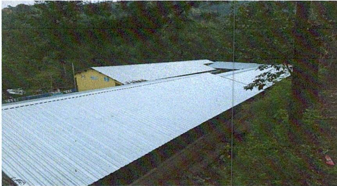
Foto1: Culminacion de instalación de la lamina troquelada calibre 24 en aulas y cocina
